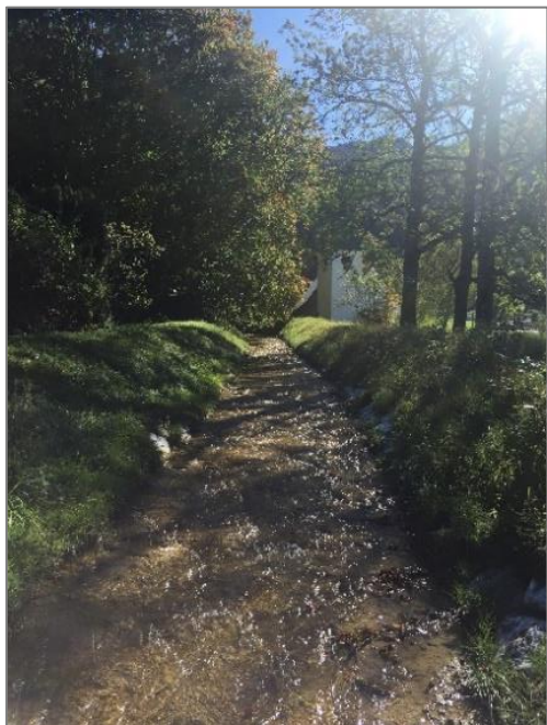
Abbildung 1: Aufgesattelter Lochgraben, Blick stromaufwärts Richtung evang. Kirche (Stand Oktober 2020)
