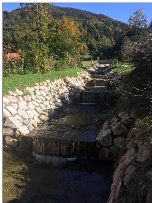
Abbildung 4: Lochgraben - Sperrenstaffelung oberstrom (Stand Oktober 2020)
