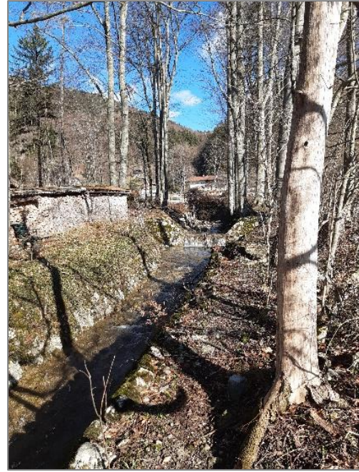
Abbildung 6: Lochgraben, Blick Richtung Brücke Amselweg (Stand Februar 2022)
