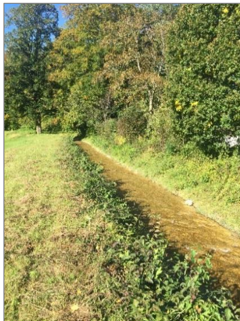
Abbildung 2: Lochgraben mit Sohlverbau und Ufersicherung auf Höhe Beginn neue Trasse (Stand Oktober 2020)
