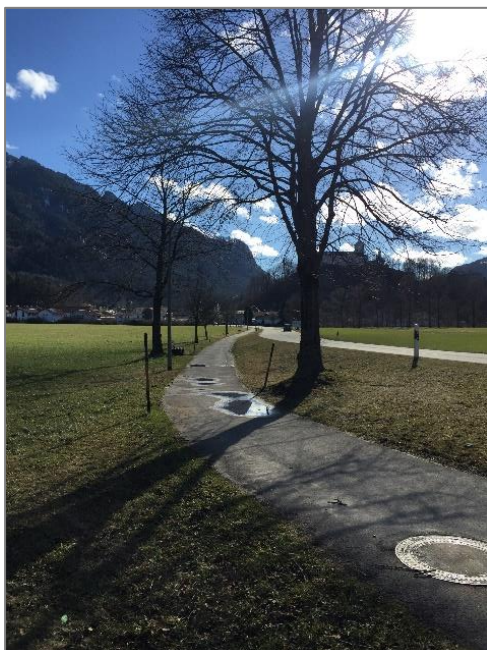
Abbildung 11: Bereich Kreuzung Staatsstraße und neues Gewässerbett (Stand Februar 2022)
