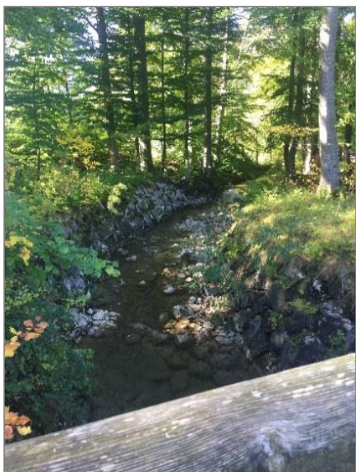
Abbildung 3: Lochgrabe mit Blick von Brücke Amselweg stromabwärts (Stand Oktober 2020)
