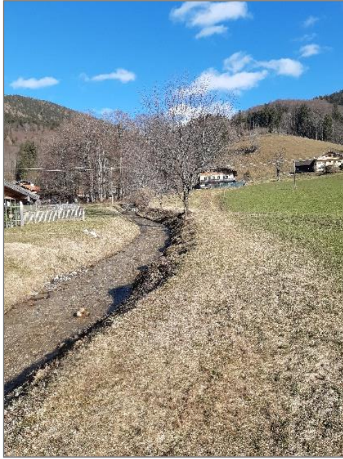
Abbildung 5: Lochgraben, Bereich Konsolidierungssperre 7 (Stand Februar 2022)
