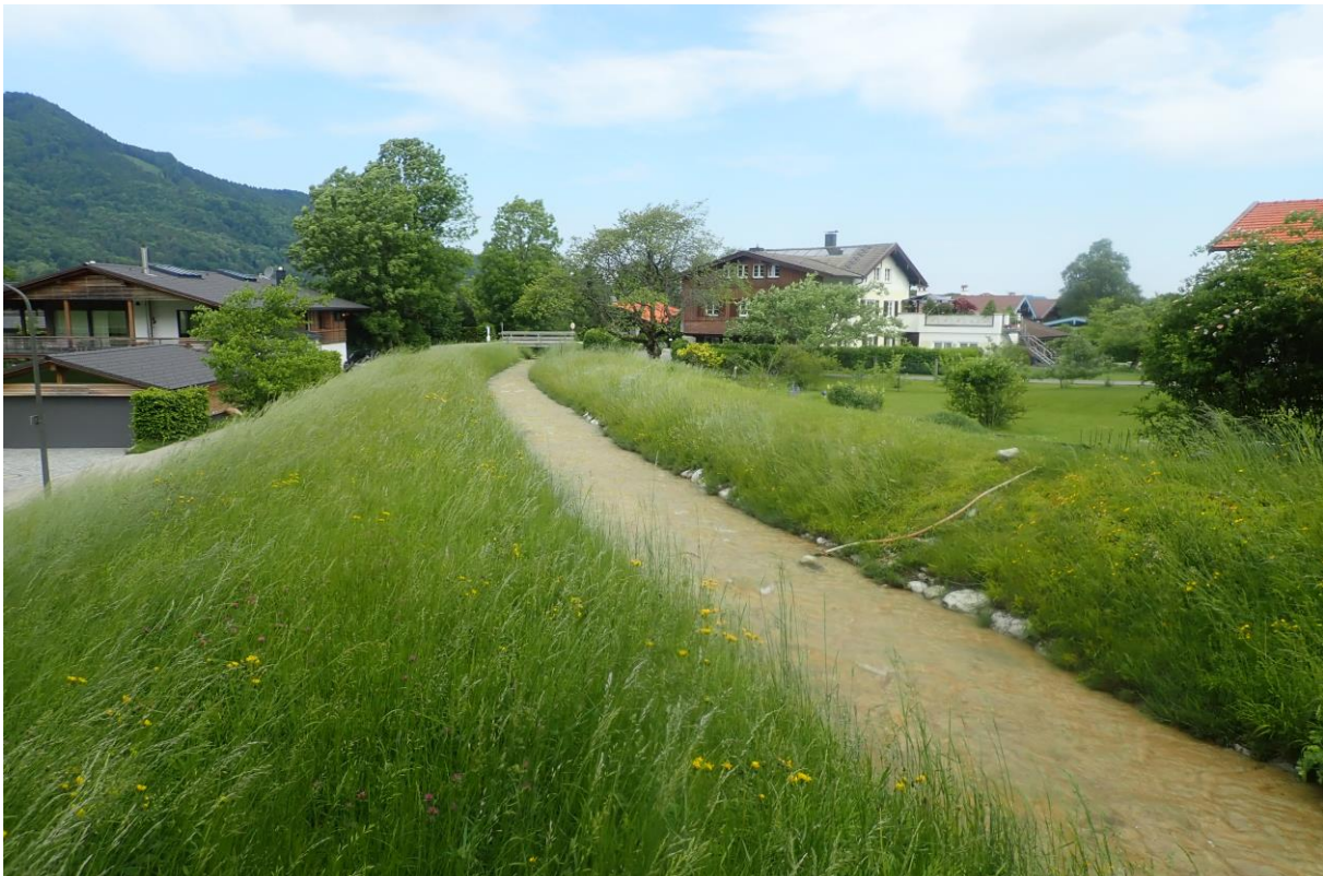
Abb.: Lochgraben, Blick westl. der Evangelischen Kirche nach Westen
