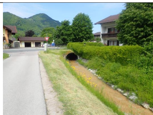
Lochgraben im Bereich der Staatstraße, Ortsmitte
