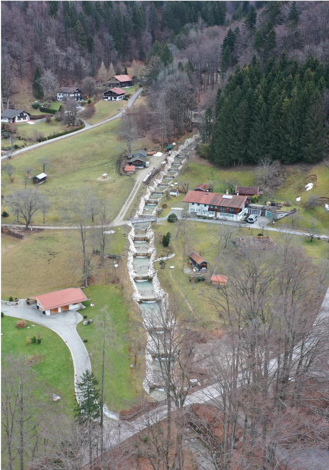
**Abbildung 2: Sperrenstaffelung Lochgraben oberstrom Brücke Amselweg. Im Hintergrund ist die sanierte Geschieberückhaltesperre zu erkennen. Blick von Westen.**
