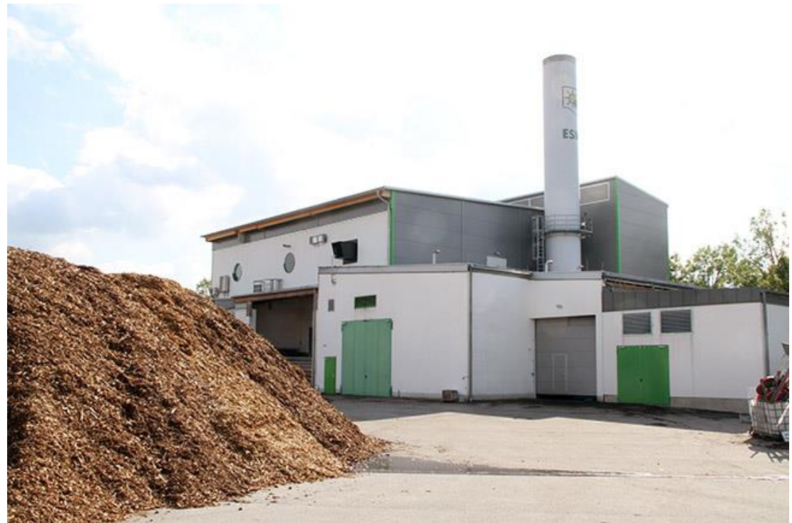
Biomasseheizkraftwerk mit Hackschnitzellager (Altötting)
